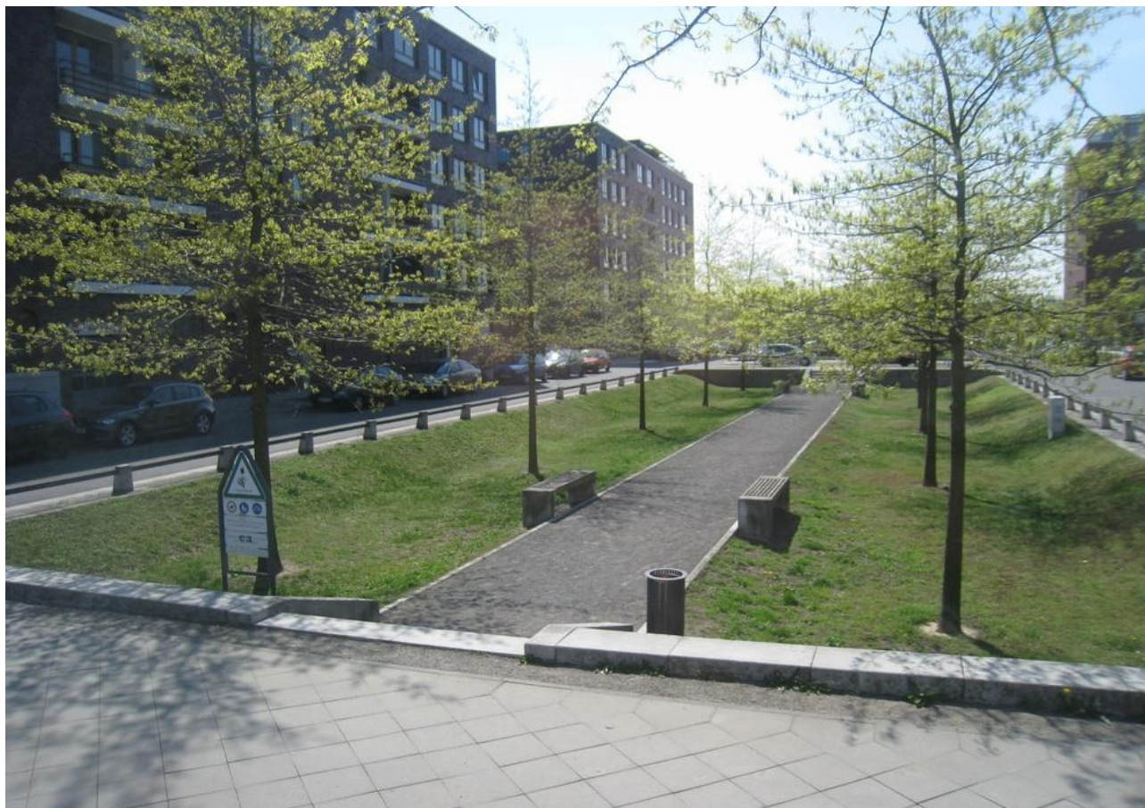
Obr. 1 – Příklad povrchového vsakování dešťové vody z komunikací do zasakovacích průlehů. (Berlin, DE)
