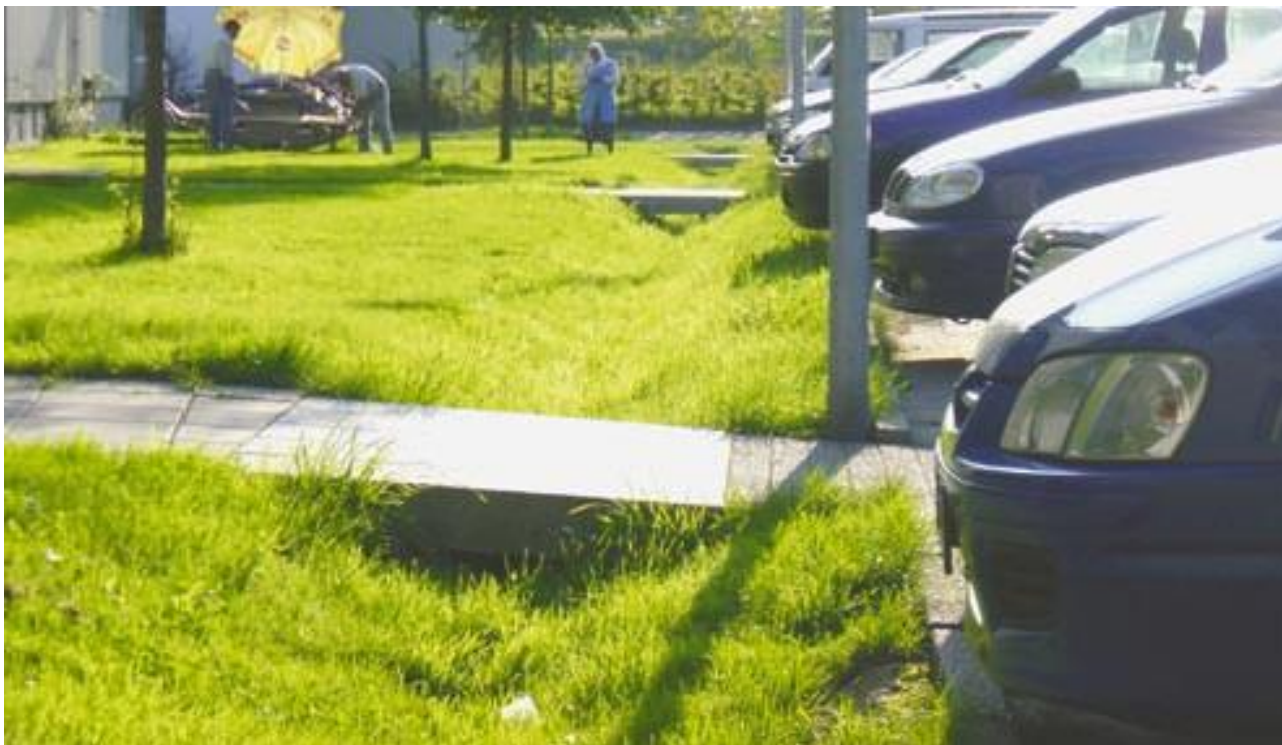
Obr. 2 – Příklad povrchového vsakování dešťové vody z komunikací parkoviště
